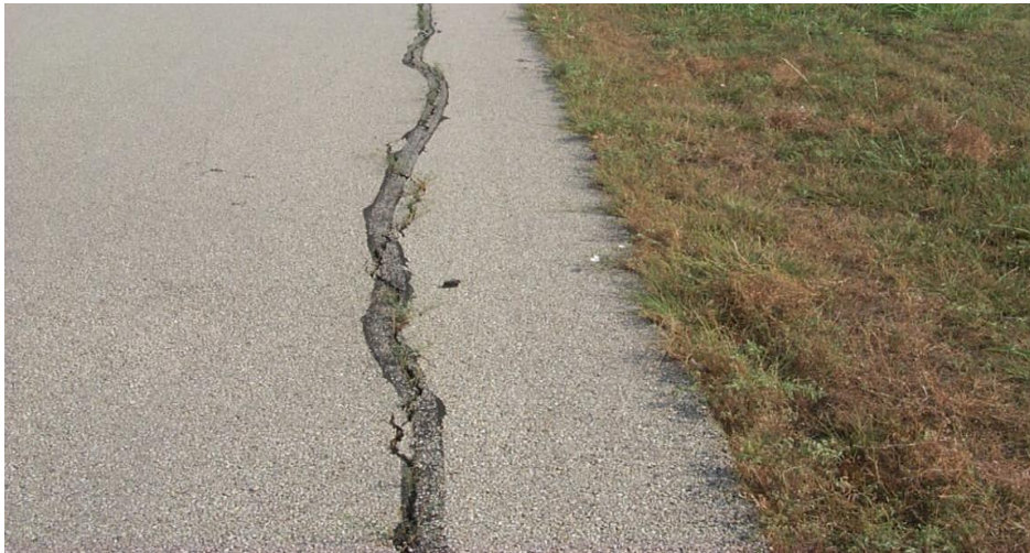
Figure 1.13 Edge Cracking
